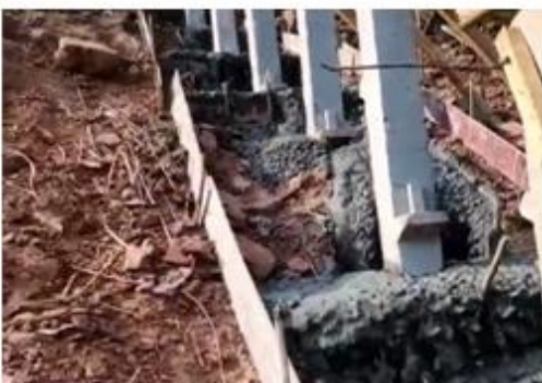
Заливка бетона в горах
